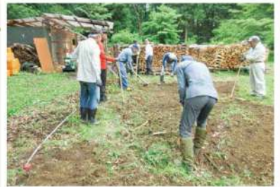
薪ステーション整地
