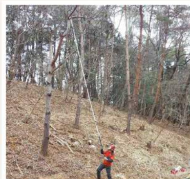
電線に掛かりそうな枝を高枝ノコで除去
