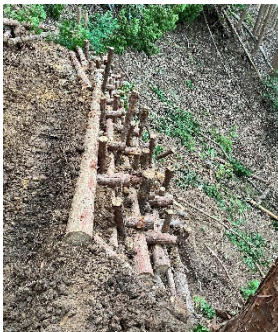
伐採木の一部は作業道整備の土留めに活用
