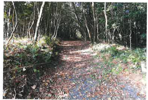
除伐、拡幅して整備した林内作業道
