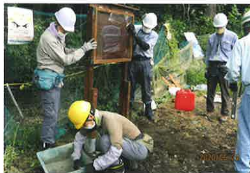
掲示板の設置作業
