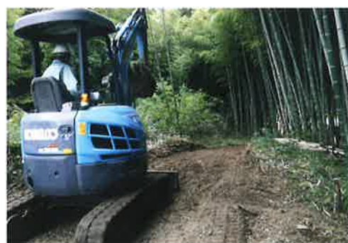
作業道の整備
