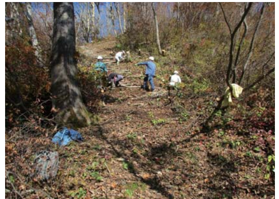
歩道での階段づくり作業
