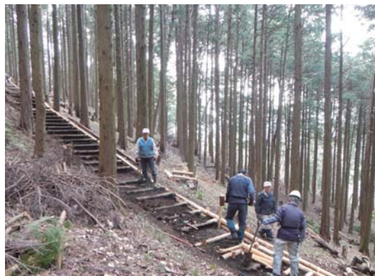
歩道の補修作業
