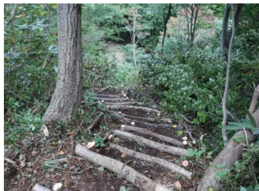
整備後の歩道
