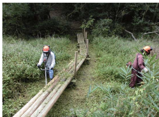
歩道の整備状況
